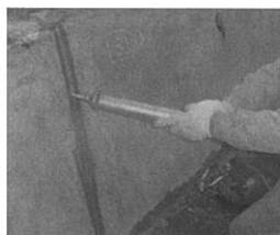
目地への施工状況
