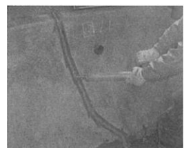
ひび割れへの施工状況
